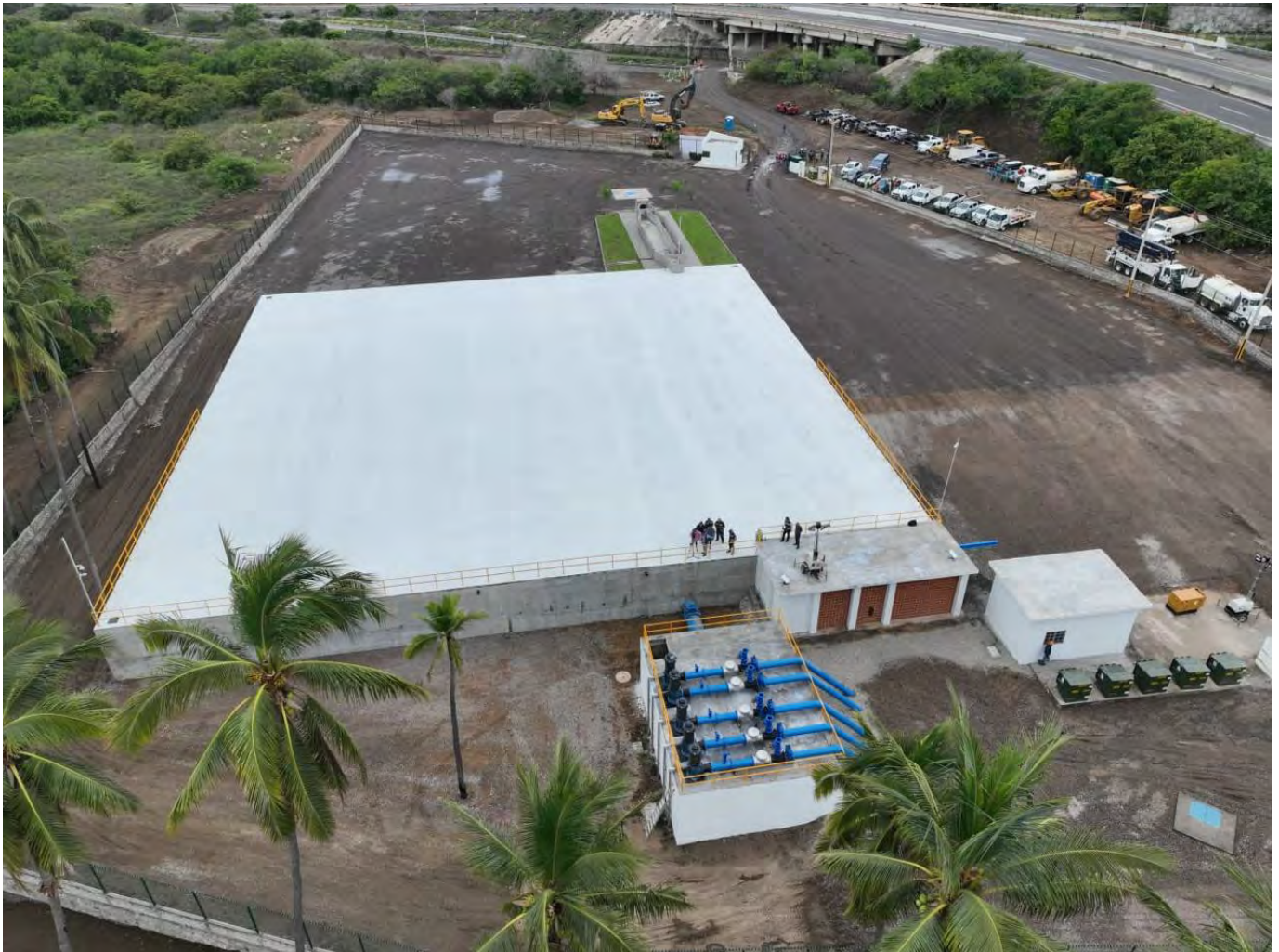
TANQUE "EL EDEN" ACUEDUCTO ARMERIA-MANZANILLO.
